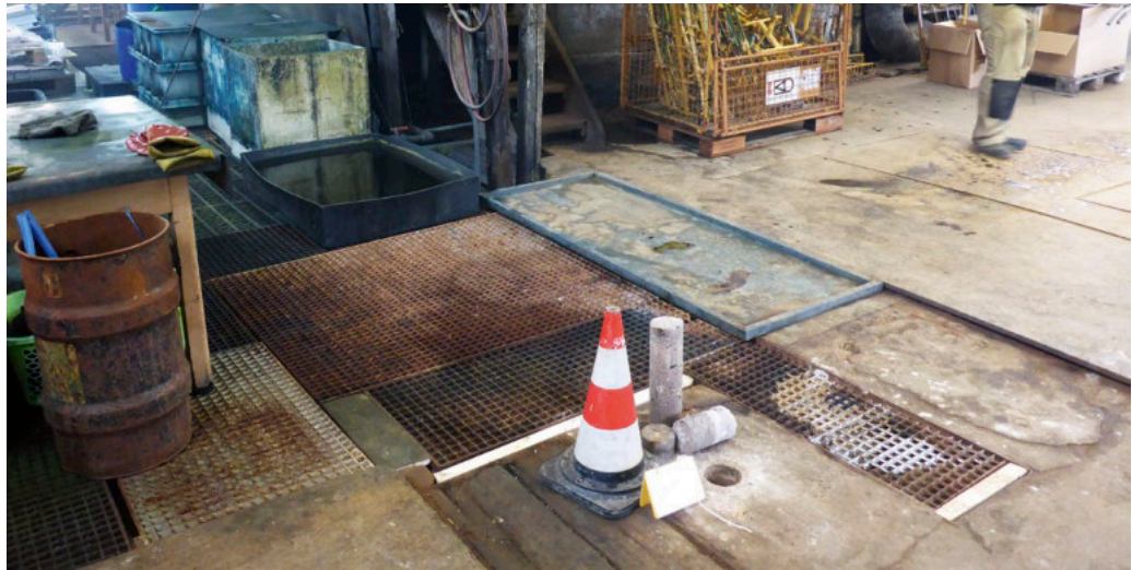
Kernbohrung in einem galvanischen Betrieb
