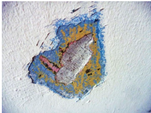
Links: Mehrere Farb- und Spachtelschichten übereinander
