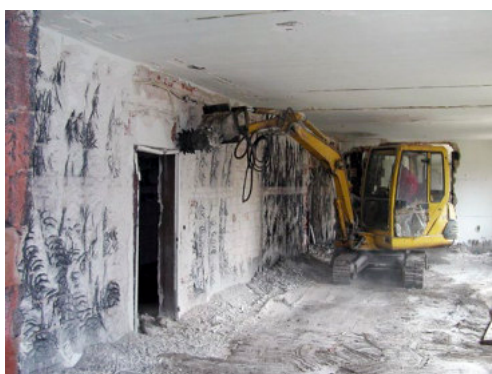
Links: Entfernen von Wandputz mit der Handfräse
