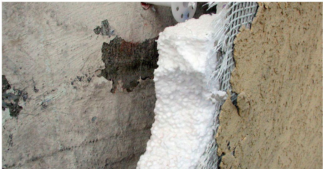
Polystyrol-Dämmstoff in einem Wärmedämmverbundsystem
