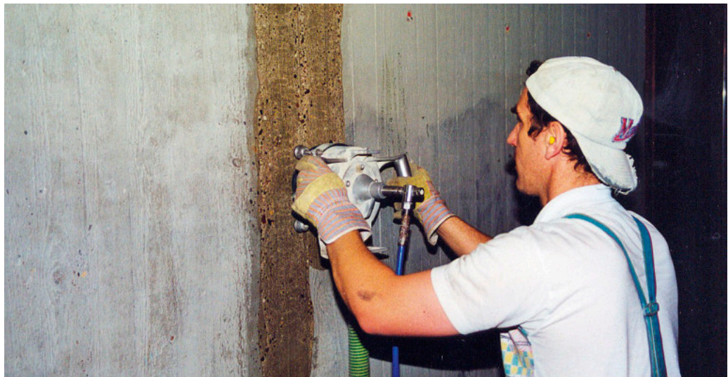
Abtrag mit einem Hochdruckwasserstrahl (HDW)
