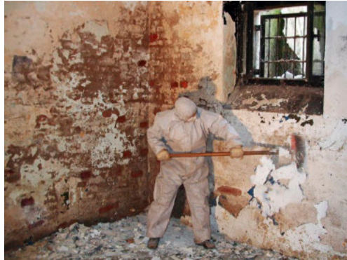
Rechts: Freigelegtes Mauerwerk nach Abstemmen des Putzes
