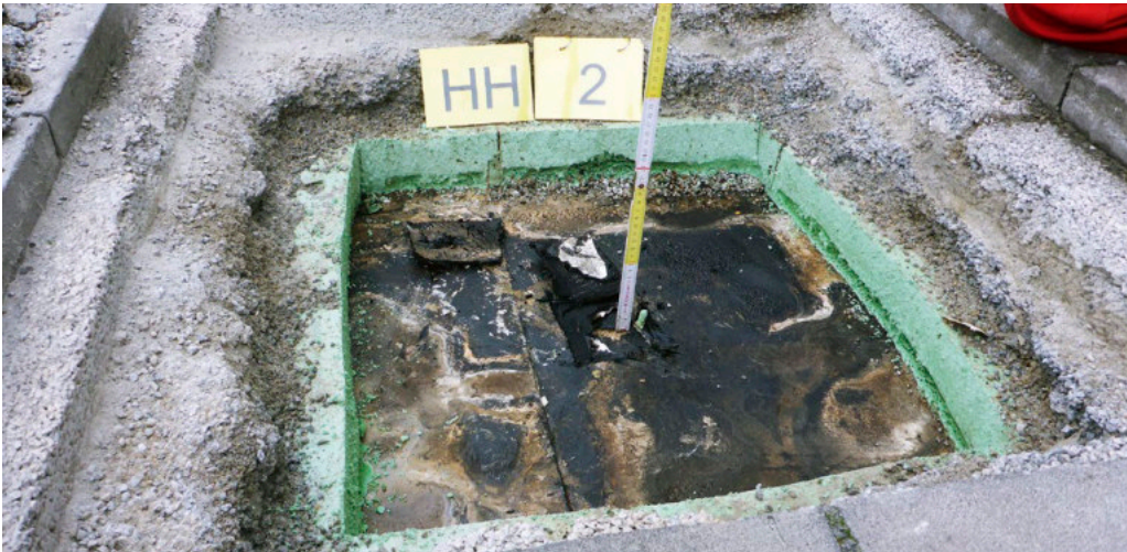
Bestimmung des Schichtaufbaus einer Dachabdichtung
