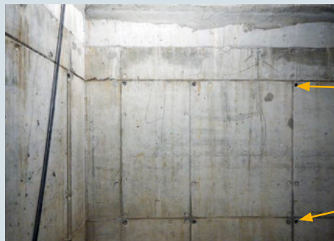
Ortbetonwände: An den Eckpunkten der ehem. Schalungstafeln sind Rohrhülsen im Beton vergossen.
