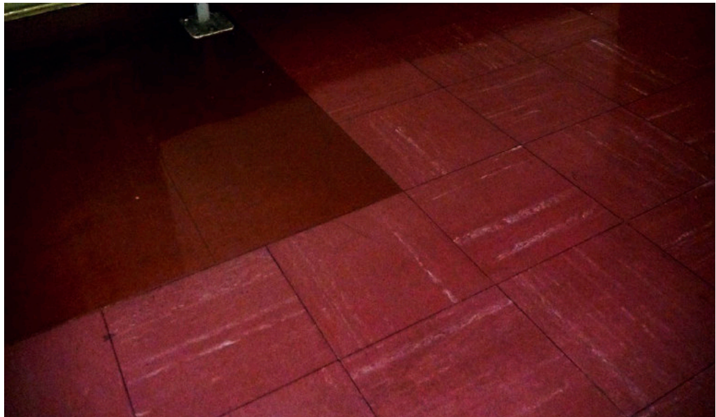
Bodenbelag aus Floor-Flex-Platten
