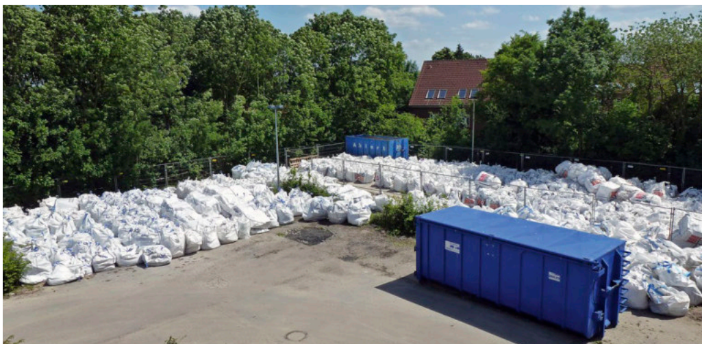
Oben: Kleinteiliger Abbruch eines Hochhauses
