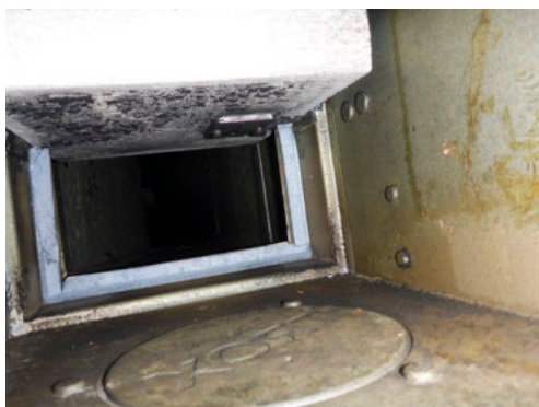
Links: Entlüftungsschacht mit Asbestzement
