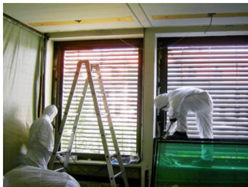
Links: Ausschneiden von elastischen Fugenmassen an Fenstern
