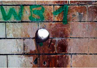
Kernbohrung im Rahmen einer Erkundung
