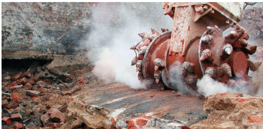
Staubfreisetzung an einer Fräse
