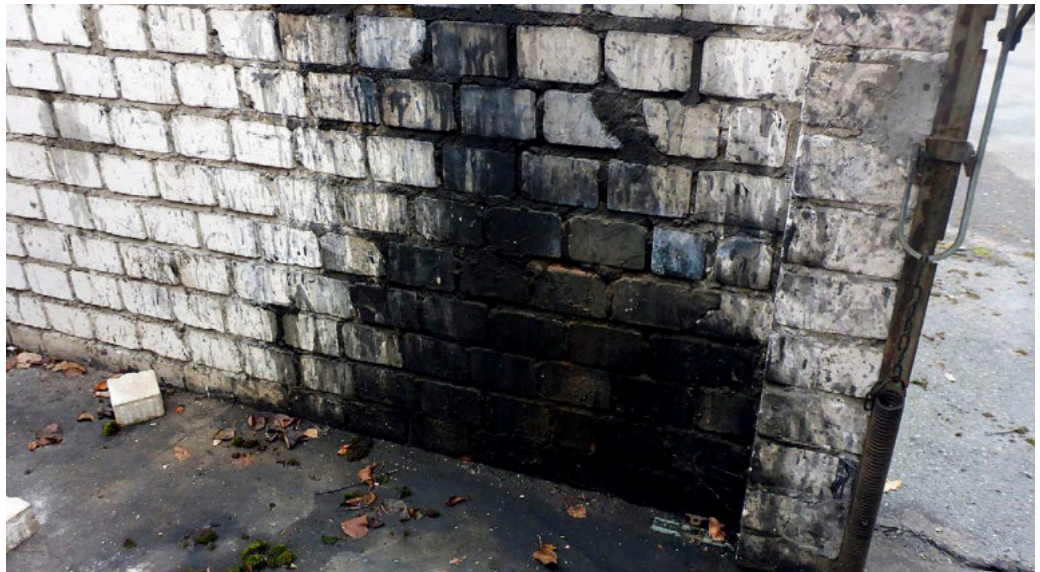
Nutzungsbedingte Mineral- ölkohlenwasserstoff (MKW)- Verunreinigung
