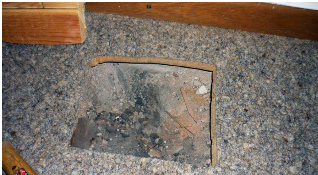
Schlacke als Fehlbodenfüllung
