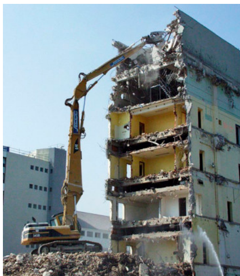
Kontrollierter Rückbau eines Verwaltungsgebäudes
